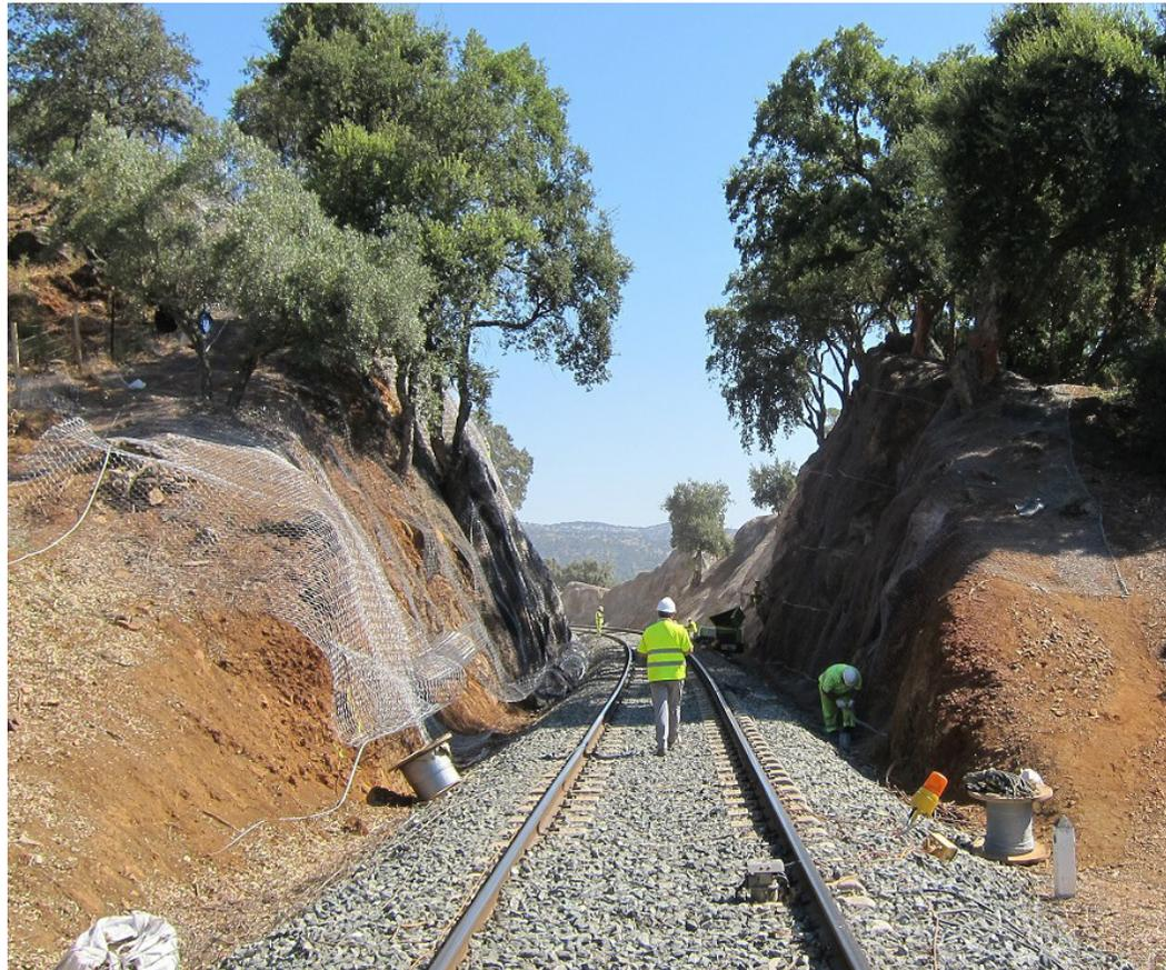
extremos y anclados en una cuadrícula de mayor intensidad que la presente. Previo al inicio de estas actuaciones y una vez finalizados los trabajos de saneo, la D.O. comprobará el estado de la superficie de los taludes y replanteará las actuaciones de la instalación de las medidas de contención.
